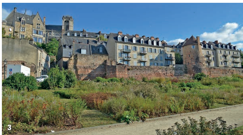
3 - L'enceinte romaine autour du Mans.
